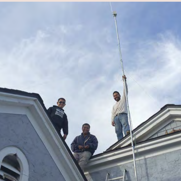
Volunteers mount the antennae on the Fresno Remnant Church building. Jóvenes voluntarios instalan la antena en el edificio de la Iglesia de Fresno Remanente.
